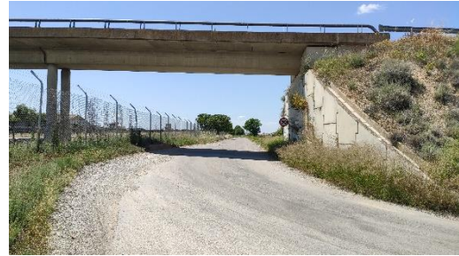
Imatge 92. Vista del vial lateral, amb el pont del carrer Vinyes del Mig
