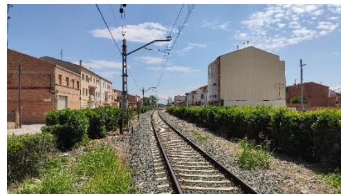
Imatge 50. Vista de la via ferroviària R12 i RL3 des del pas a nivell del carrer Sant Miquel
