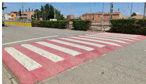
Imatge 40. Pas elevat al carrer Via Fèrria, a tocar de l'estació
