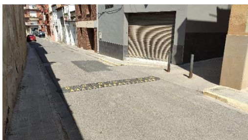
Imatge 35. Banda reductora en bon estat al carrer del Forn
