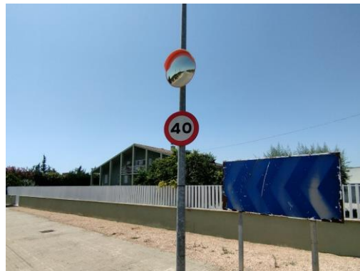
Imatge 131. Mirall per a millorar la visibilitat a la intersecció entre la ronda Nord i Oest.
