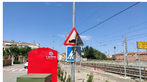
Imatge 4. Senyals verticals deteriorades al carrer de la Via Fèrria
