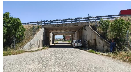
Imatge 96. Vista del pas inferior a la A-2 per on discorre el vial
