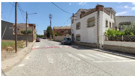
Imatge 11. Pas de vianants i esquena d'ase al carrer Sant Jordi amb senyalització horitzontal força deteriorada
