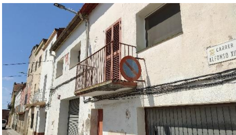
Imatge 3. Senyalització vertical de prohibició de l'estacionament deteriorada al carrer Alfons XIII
