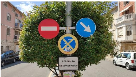
Imatge 5. Senyals indicatives de circulació en bon estat i senyal de prohibició de l'estacionament deteriorada a la pl. Major
