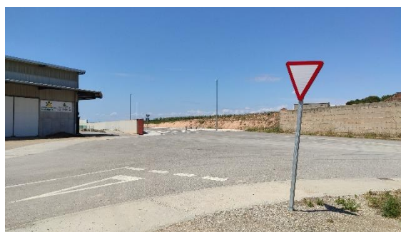
Imatge 112. Emplaçament reservat per a la construcció de la rotonda del vial oest, a tocar de la cooperativa Sant Miquel
