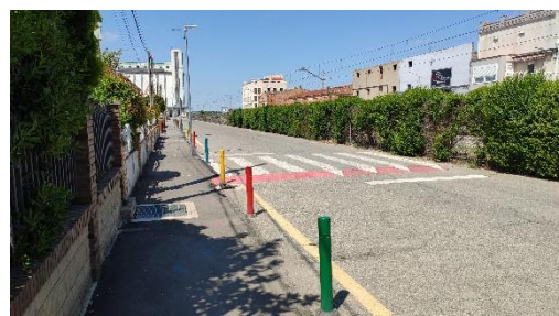
Imatge 54. Pas per a vianants (camí escolar) habilitat a la calçada i pas elevat per a moderar la velocitat al carrer Via Fèrria
